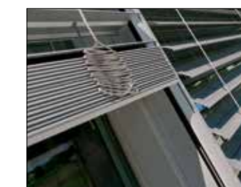
Softführungsschiene mit patentierter geräuschdämpfender Gummieinlage sorgt für geräuscharmen Lauf
